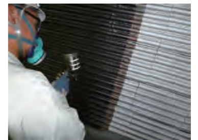
腐食対策用コーティング
